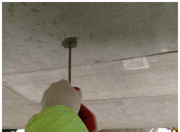
탄산화깊이 측정 현황
