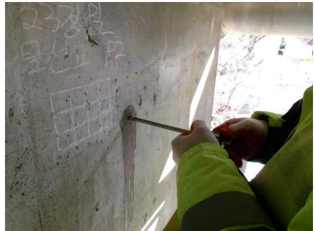
탄산화깊이 측정 현황
